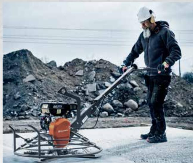
**PALE FLOTTANTE EN ACIER** Les pales flottantes sont utilisées pour lisser la surface du béton dans la phase initiale de finition du béton. Les pales flottantes Husqvarna ont une surface presque plate, créant un effet d'aspiration entre la pale et la surface. Cela déplace le béton d'une position supérieure à une position inférieure sur la dalle.
